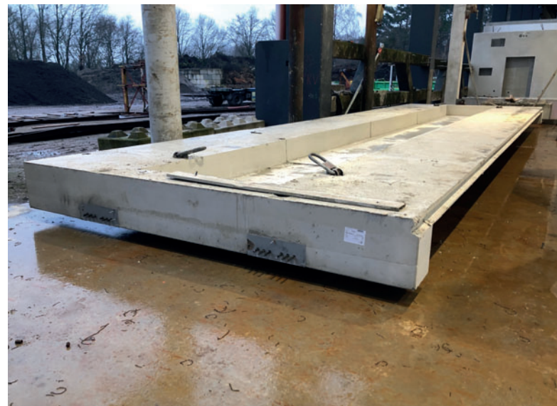
Vorgefertigtes weitgespanntes Deckenelement
