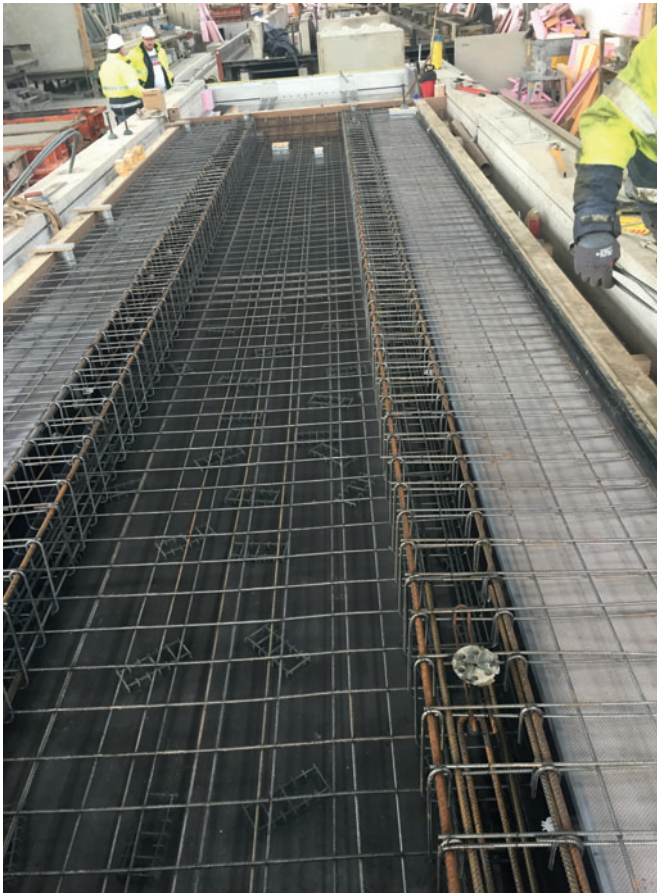
Bewehrung für Deckenelement im Spannbett
